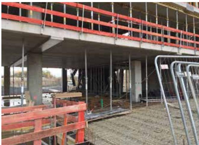
*Sicht im Erdgeschoss – die zusätzliche Abstützung entlang der Einsturzkante ist bereits aufgebaut.*
