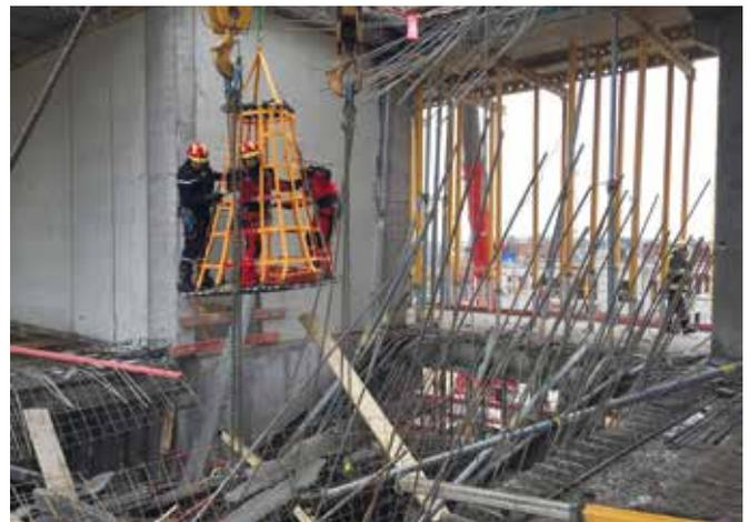
Rettung des Verschütteten mittels Rettungskorb nach dem Entfernen der Trümmer.
